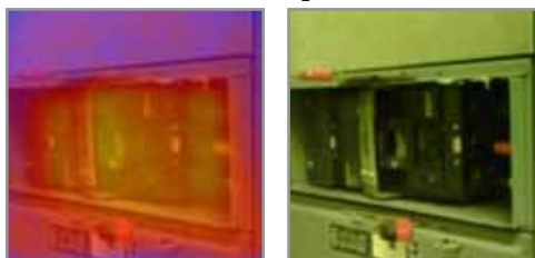
Normale temperatura operativa su un interruttore di importanza critica
