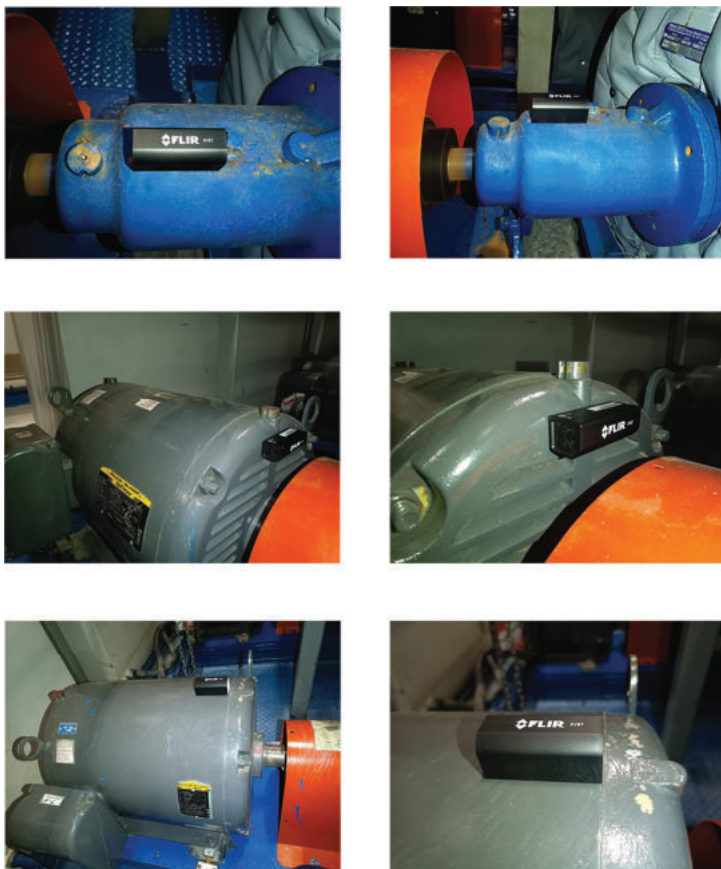
Figura 6.2 Sensori SV87 montati su macchinari.
